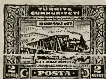
R. R. Bridge Over Kizil Irmak A70
