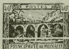
Ste. Dévote Viaduct ("Bridge of Suicides") A11
