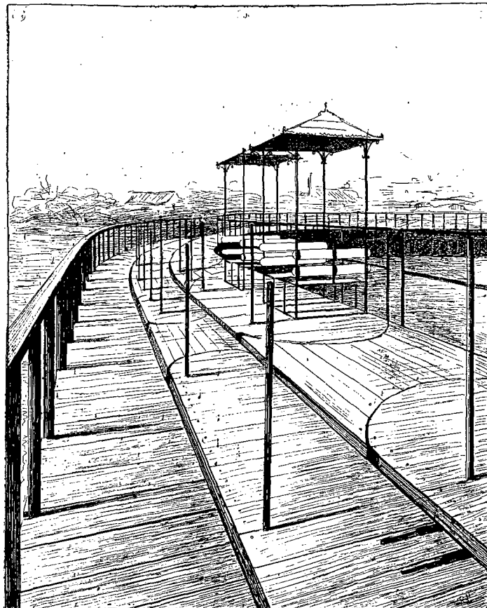
LA PLATE-FORME MOBILE. — Vue d'ensemble de l'installation.
