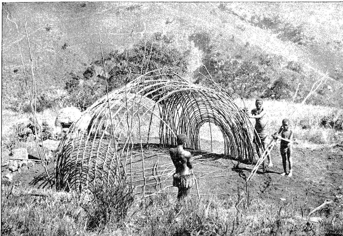
Une hutte en construction.
