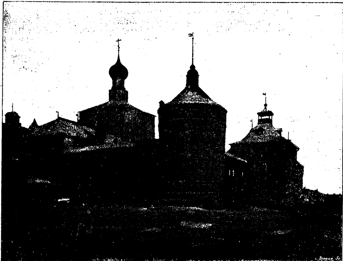
Tour restaurée du Kremlin de Rostoff.
