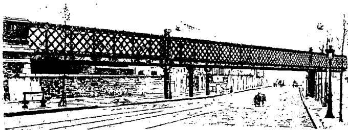
LE NOUVEAU PONT DE BERCY.
