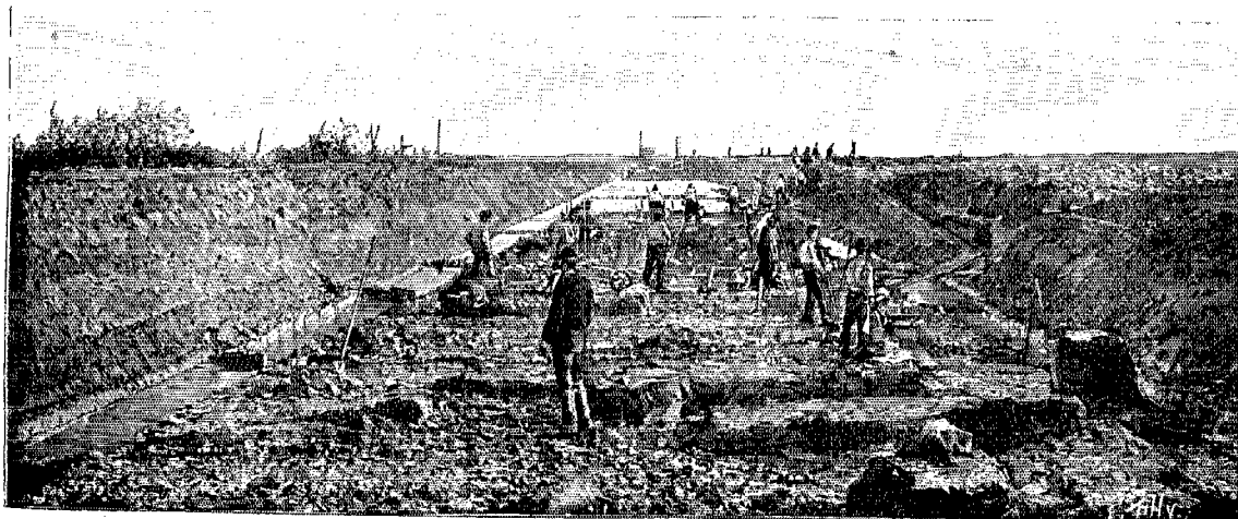
Le dessèchement des marais de Fos. — Vue d'un chantier de terrassements, d'après une photographie.
