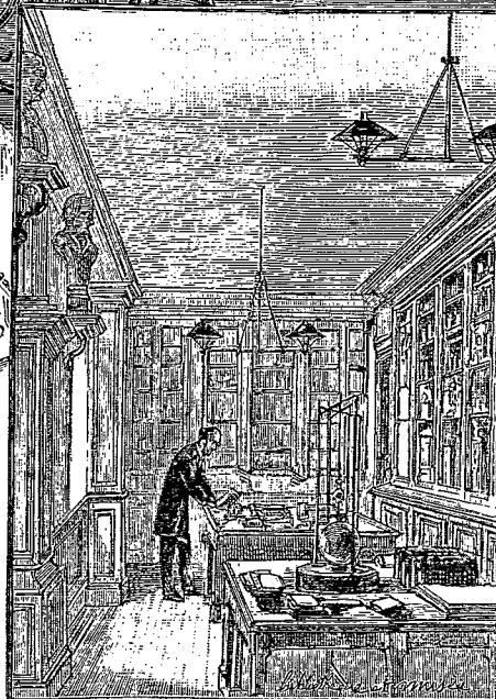
Vues intérieures de l'École d'horlogerie.
