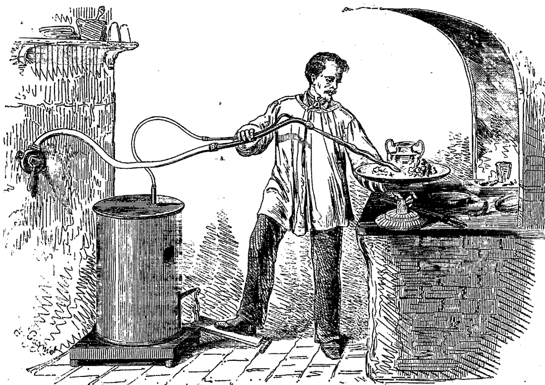
FIG. 6. — Chalumeau à gaz en usage dans les grands ateliers.
