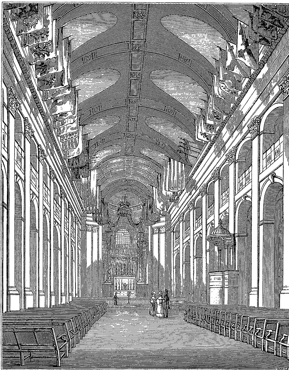
( Vue intérieure de l'église des Soldats, à l'hôtel royal des Invalides.)
