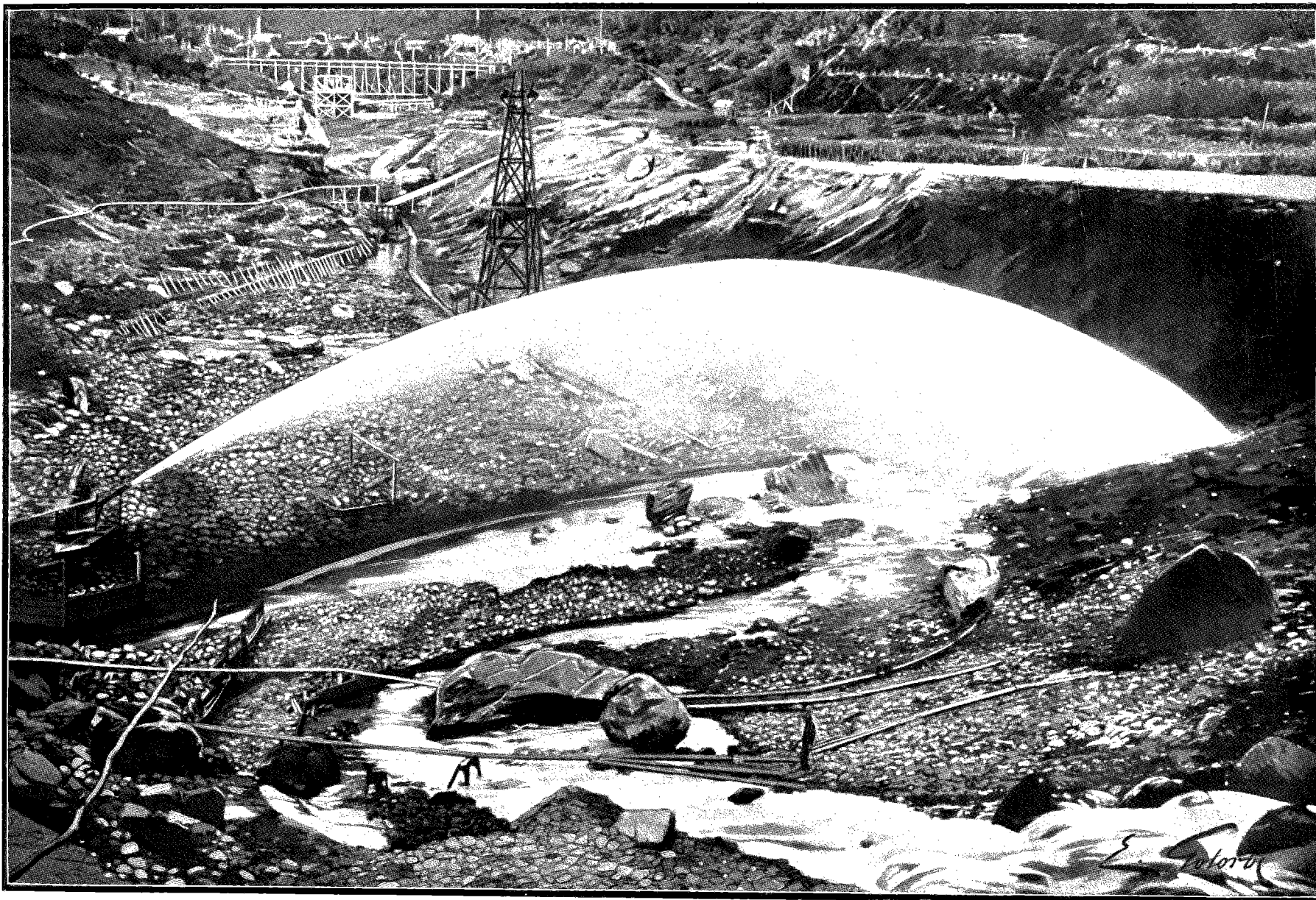
EXPLOITATION D'UN PLACER PAR LA MÉTHODE HYDRAULIQUE (PAGE 225). — PHOTOGRAPHIE DE LA ROCHE, À SEATTLE.
