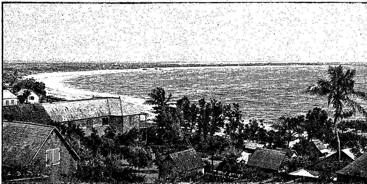
BAIE DE TAMATAVE 1 .
