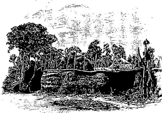
HABITATION A L'OUEST DU LOGÔNE 1 .
