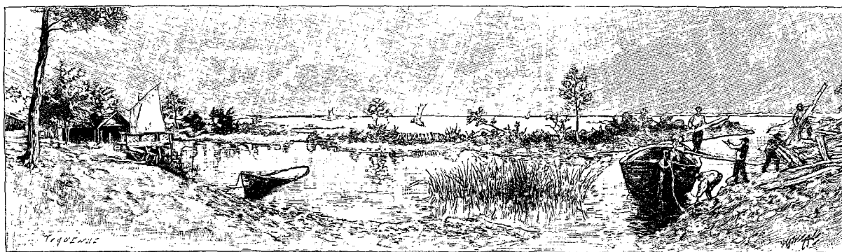
Déchargement du bois.
