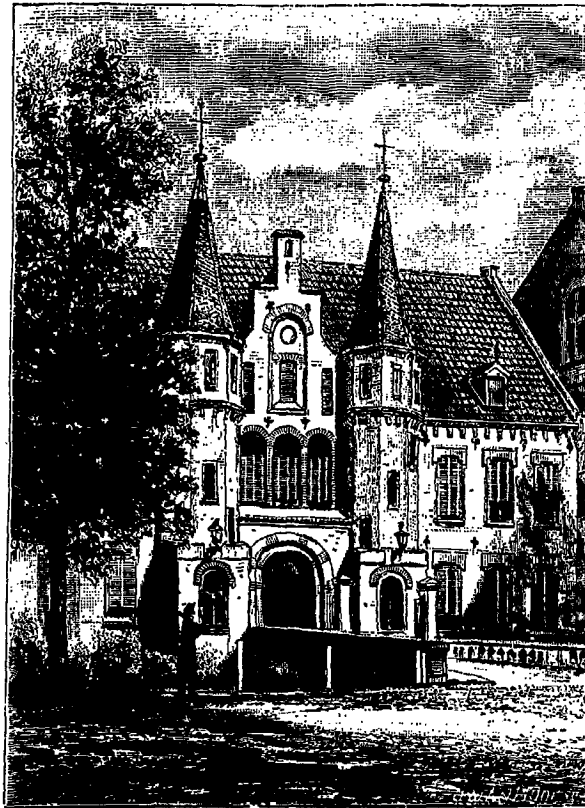
Maison de détention à Leeuwarden.
