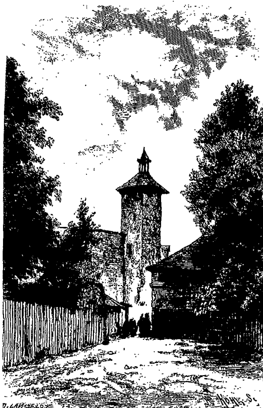
Ancienne tour du Bollwerk à Mulhouse (Voy. p. 172). — Dessin de D. Lancelot, d'après une photographie de Kohler-Dietz.
