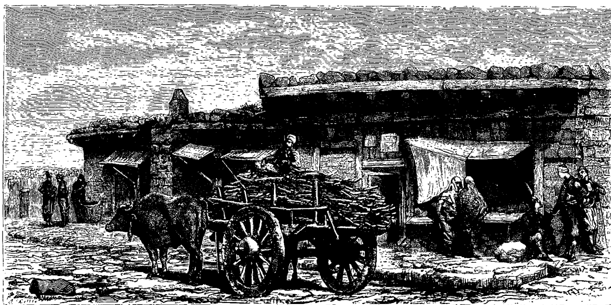
Boutiques à Baïbourt.
