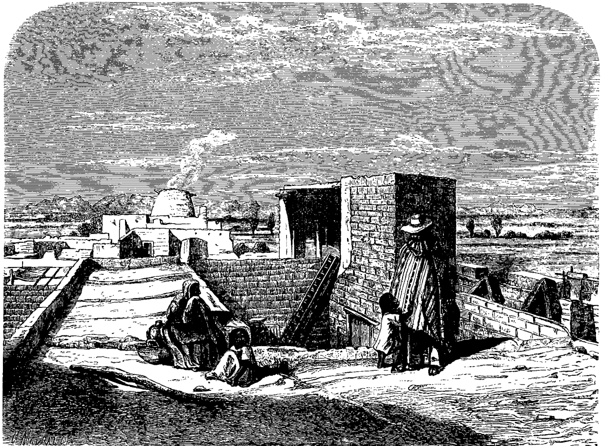
Terrasse d'une habitation de Corralitos.
